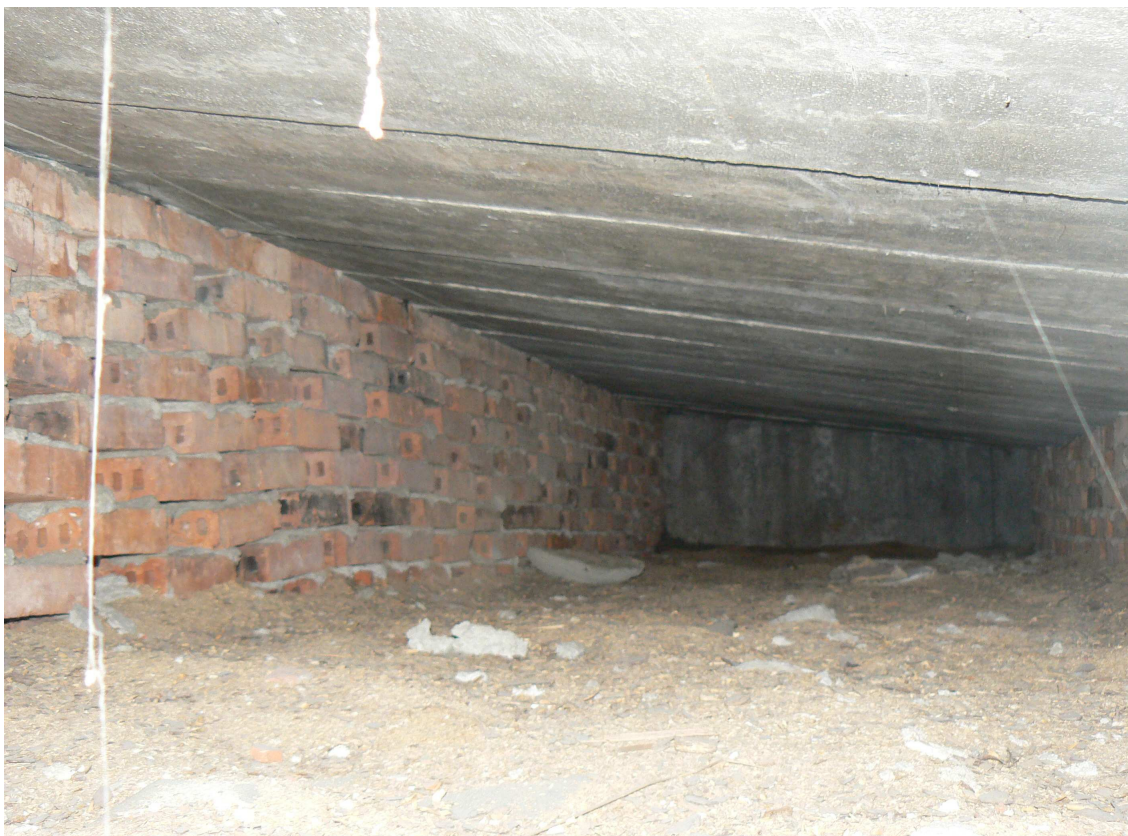
Fot. NR 4 . Przestrzeń stropodachowa nad głównym budynkiem szkoły ( obiekt „A”)
