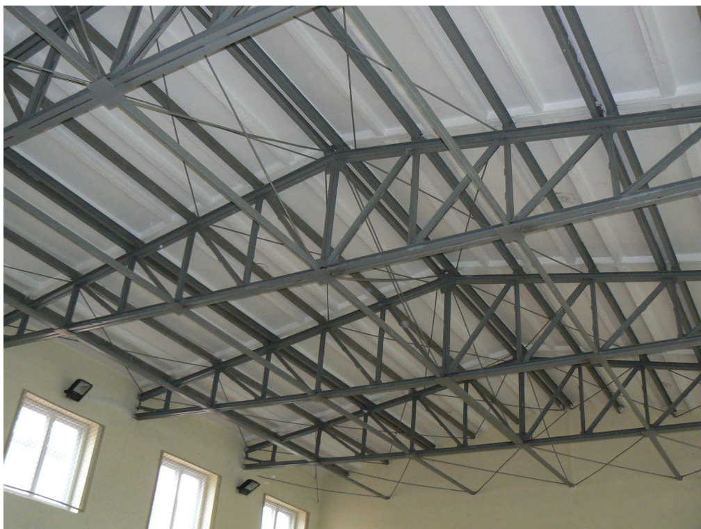
Fot. NR 2 . Stropodach nad salą gimnastyczną (sala po stronie zachodniej)
